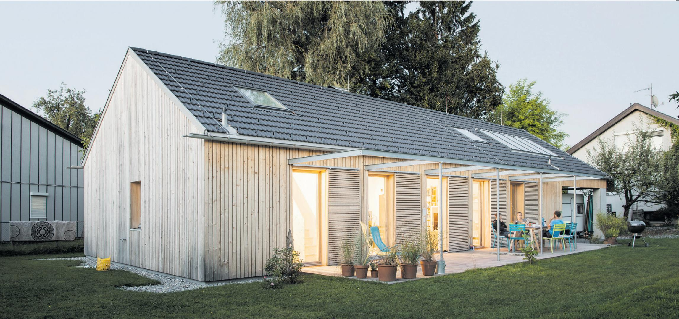
**RICHTUNG SÜDWESTEN** liegen auf dem Dach Solarelemente als Unterstützung für die Fußbodenheizung. Als Sicht- und Sonnenschutz ist jeder der Fenstertüren ein aus horizontalen Holzelementen gebautes Schiebeelement zugeordnet.
